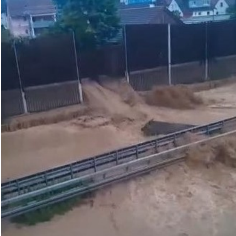
Durchbrochene Lärmschutzwand an der B10 (Foto: Feuerwehr Ebersbach)
